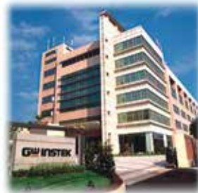
Штатное здание и фабрика, Тайвань
