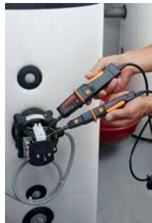
Измерение напряжения на бойлере.
