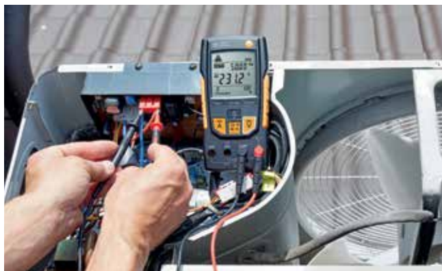
Измерение напряжения на наружном блоке кондиционера с testo 760 .
