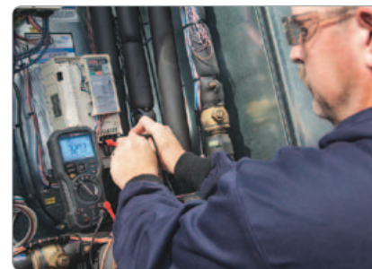
Повышенная чувствительность в режиме проверки преобразователей частоты
