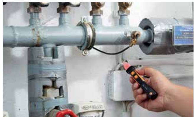
Проверка напряжения в распаечной коробке с testo 745 .
